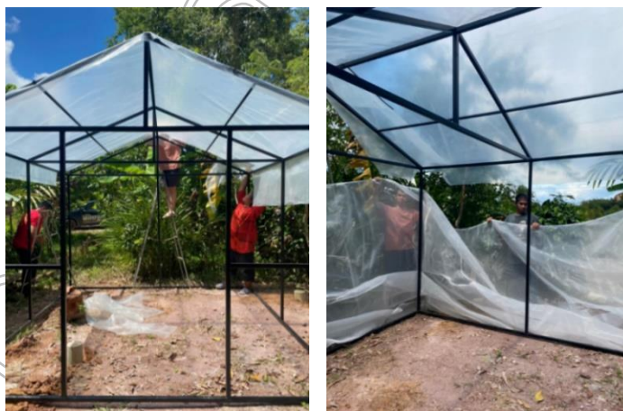
ภาพที่ 3 แสดงขั้นตอนการติดตั้งพลาสติกคลุมโรงเรือนและมุ้งกันแมลง
