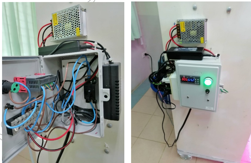
ภาพที่ 15 และ 16 แสดงการติดตั้งชุดกล่องคอนโทรลในระบบไฟฟ้า
