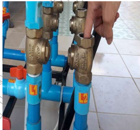
ภาพที่ 7 ไล่ฟองอากาศออกจากท่อโดยการกดลิ้นน้ำ
