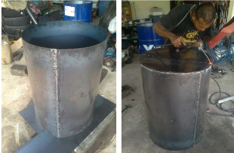
ภาพที่ 4 และ 5 แสดงลักษณะการเชื่อมแผ่นเหล็กทรงกระบอกเป็นถังชั้นนอก
