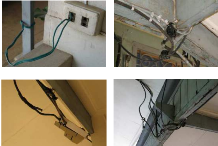
รูปที่ 7 การใช้งานและการบำรุงรักษาที่ไม่ปลอดภัย
