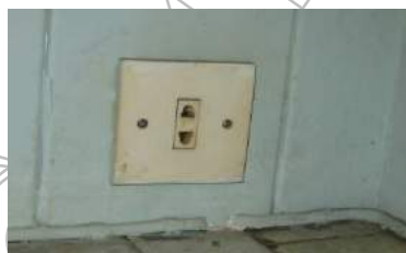
รูปที่ 2 ระบบไฟฟ้าแบบเดิมที่ไม่มีระบบสายดิน
