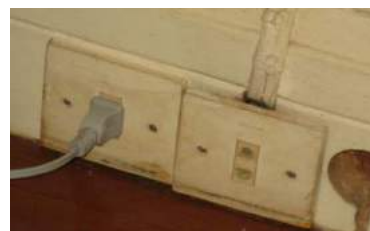
รูปที่ 2 ระบบไฟฟ้าแบบเดิมที่ไม่มีระบบสายดิน
