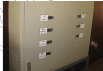
รูปที่ 10 ตู้ควบคุมหลัก (MDB) ของระบบไฟฟ้า
