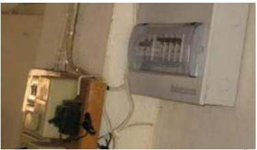
รูปที่ 5 การต่อเติมใช้งานไฟฟ้าเพิ่มขึ้น
