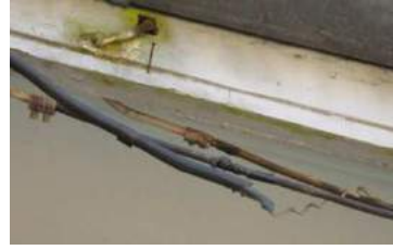
รูปที่ 3 วัสดุอุปกรณ์ไฟฟ้าที่มีสภาพเก่าและชำรุด
