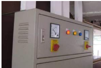
รูปที่ 10 ตู้ควบคุมหลัก (MDB) ของระบบไฟฟ้า
