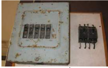
รูปที่ 3 วัสดุอุปกรณ์ไฟฟ้าที่มีสภาพเก่าและชำรุด
