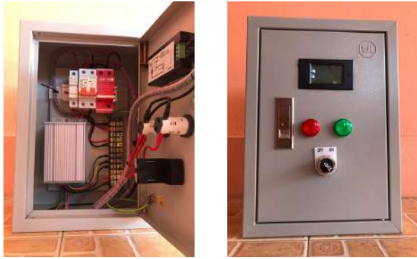
ภาพที่ 5 ตู้ควบคุมระบบปั๊มลมพลังงานแสงอาทิตย์ ภายใน และภายนอก
