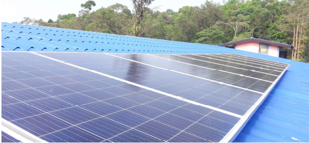
ภาพที่ 3 การติดตั้งแผงโซล่าเซลล์บนหลังคาอาคารอนุบาล
