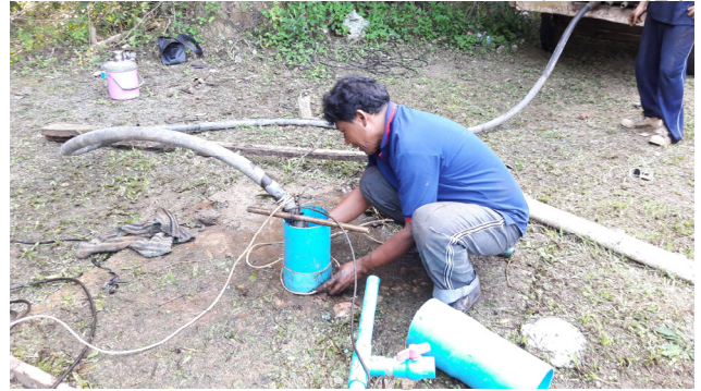
ภาพที่ 4 การล้างบ่อบาดาลก่อนทำการติดตั้ง
