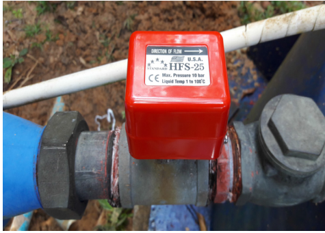
ภาพที่ 6 สวิตซ์ใบพาย และสวิตซ์ควบคุมแรงดันน้ำ
