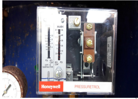
ภาพที่ 6 สวิตซ์ใบพาย และสวิตซ์ควบคุมแรงดันน้ำ
