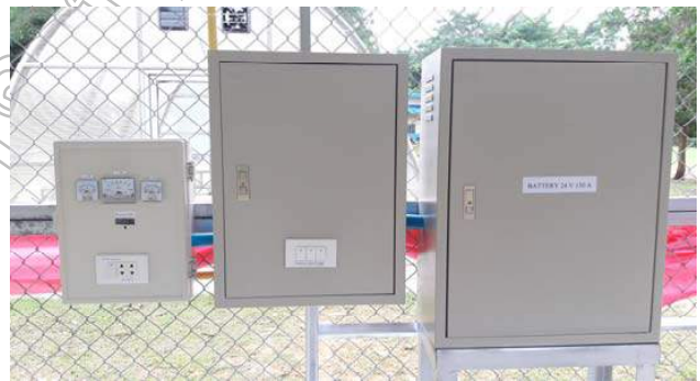
ภาพที่ 8 ชุดควบคุมจักรยานปั่นร่วมกับพลังงานแสงอาทิตย์เพื่อผลิตกระแสไฟฟ้า
