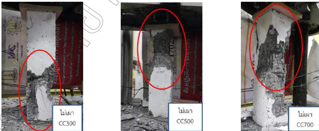
ภาพที่ 4 แสดงการวิบัติของเสาคอนกรีตเสริมเหล็กควบคุมก่อนการเผา
